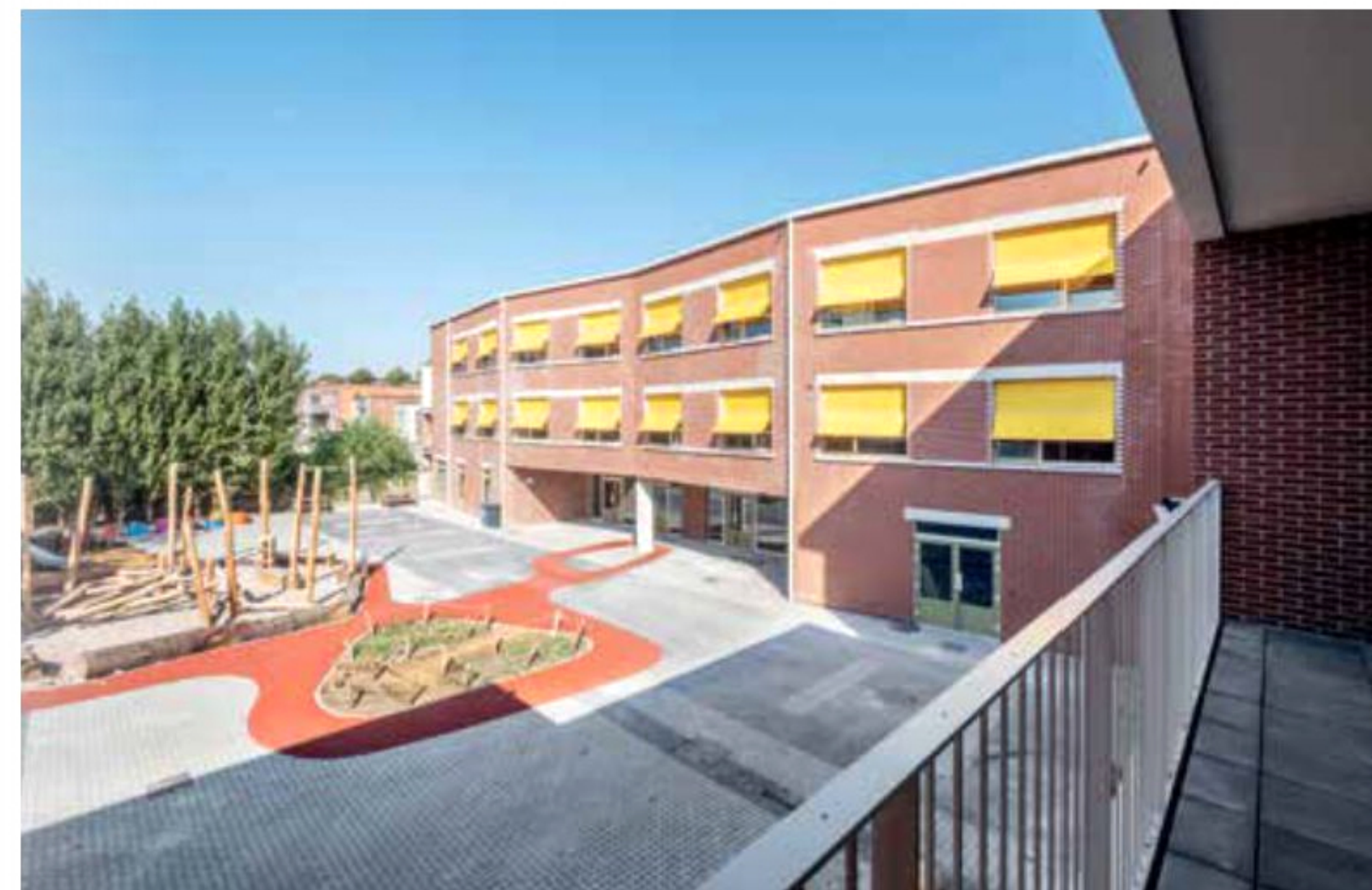
Het geheel is opgetrokken in een betonstructuur en afgewerkt met een combinatie van rode baksteen en enkele accenten van witte geglaazuurde bakstenen, wit zichtbeton en licht aluminium schrijnwerk.
