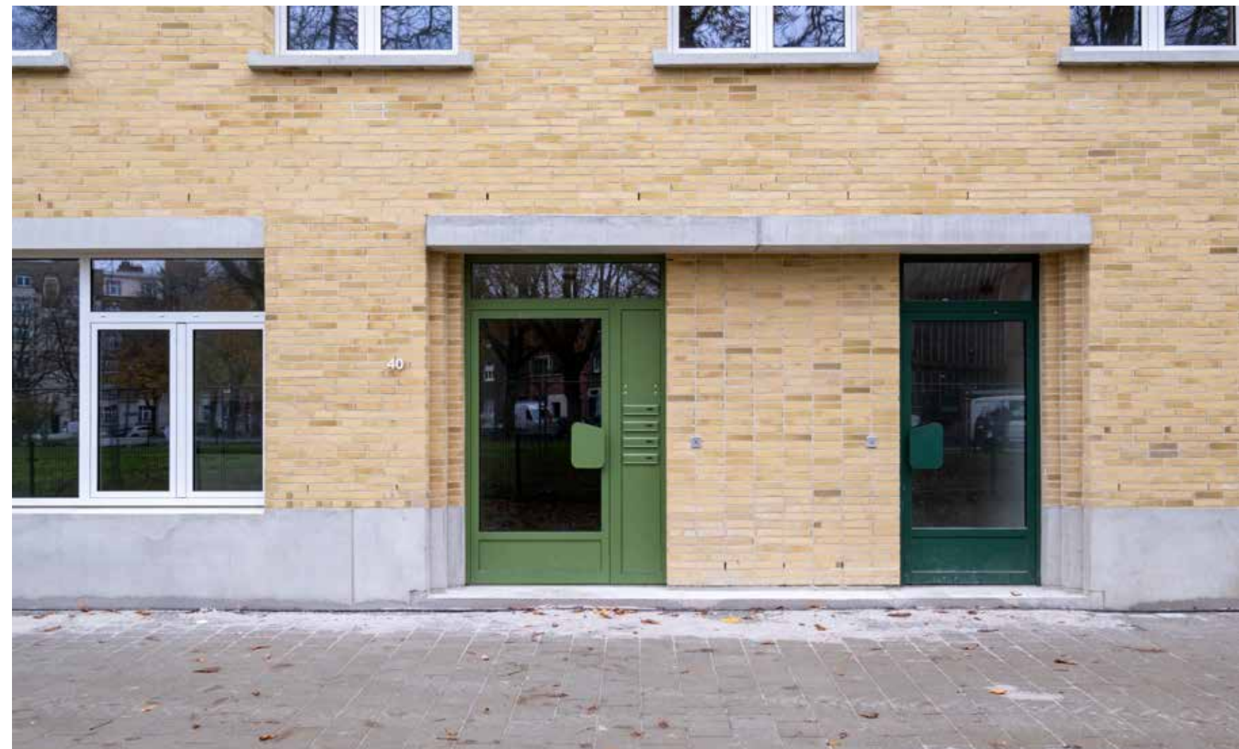
Het gekozen metselverband is een subtiel en betaalbare versie van de natuurstenen plinten in de buurt.
